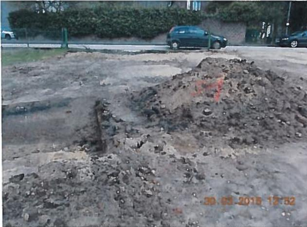
**Abbildung 26: Schurf 1 GOK 9,62m, Sohle Auffüllung 8,94 m (Boden, Bauschutt, Asche, Schlacke)**
