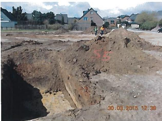
**Abbildung 30: Schurf 5 / GOK 9,77 m Sohle 8,80 m ,Boden, sandig, kiesig, Bauschutt**
