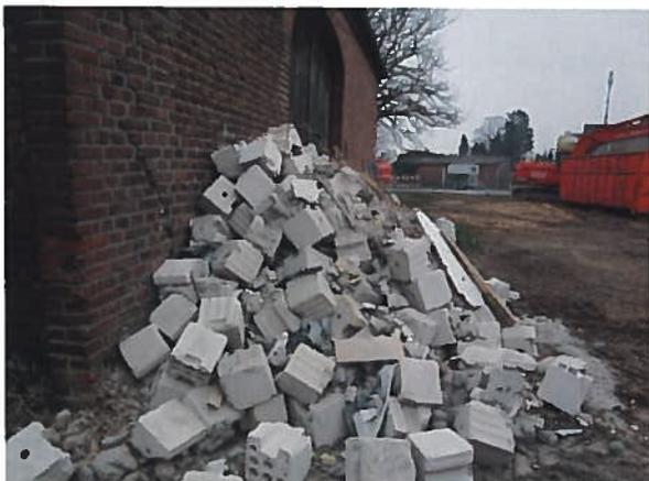
**Abbildung 5: KS-Mauerwerk / Abbruch Innenwände, Halle III**
