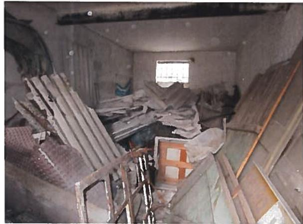
**Abbildung 4: zusätzliche Baumisch- und Asbestzementabfälle**
