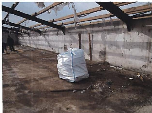
*Abbildung 10: Zusätzliche Asbestzementabfälle (Sockel)*
