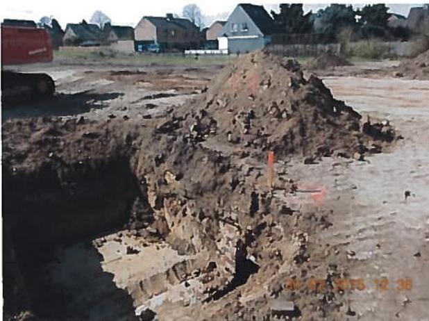
**Abbildung 28: Schurf 3 / GOK 9,86 m Sohle 8,77 m Boden, sandig, kiesig, Bauschuttreste**
