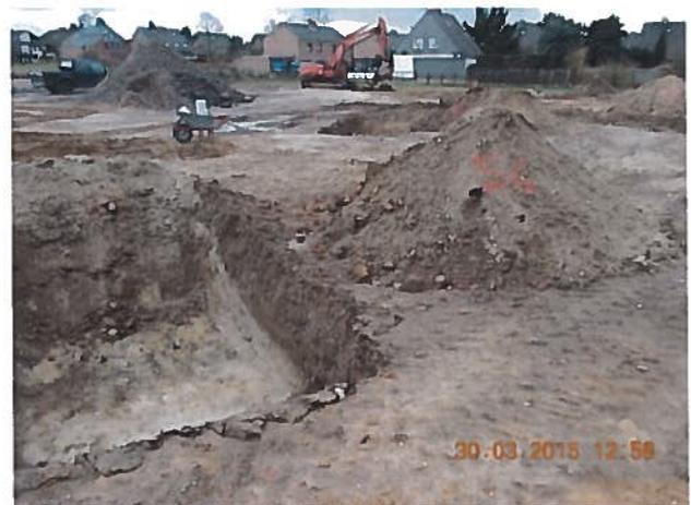
**Abbildung 31: Schurf 6 / GOK 9,81 m Sohle 8,84 m, Boden, sandig, kiesig, Aschereste, Bauschutt**
